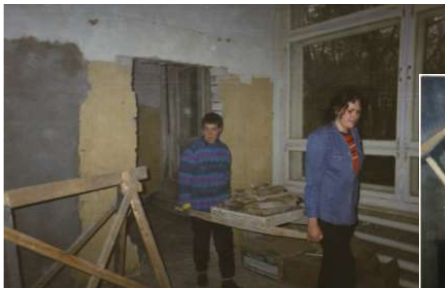
Строй отряд на ремонте здания Карачаровское шоссе 5д
